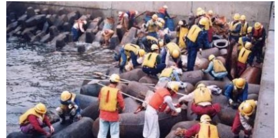
漂着した油の回収状況
